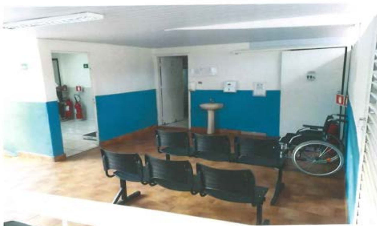
Figura 54. Sala de Curativo – UBSF Marta Helena 2 com acessibilidade
